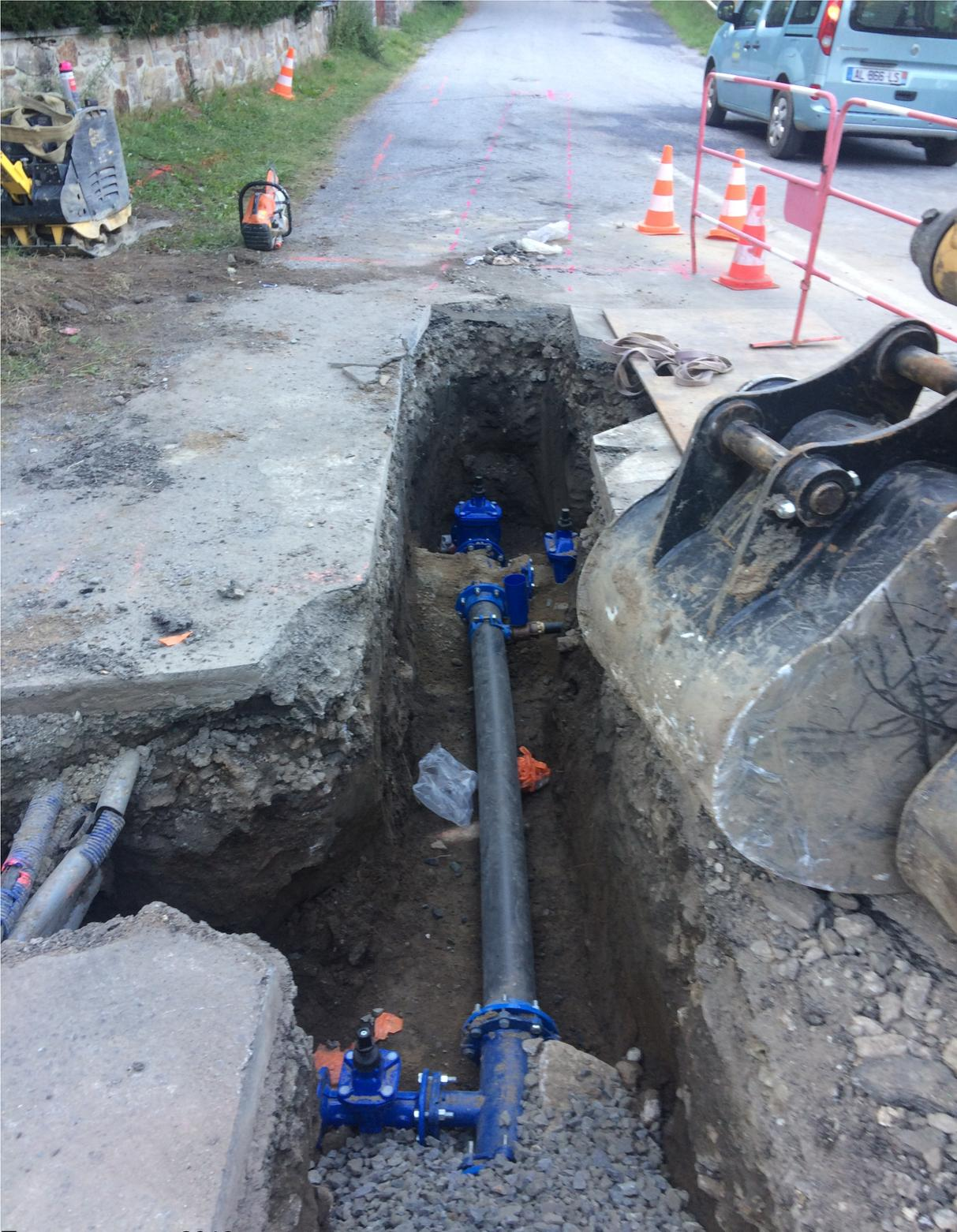
Travaux de pose des tuyaux de 150 mm de diamètre en PVC dans le fossé de la route
